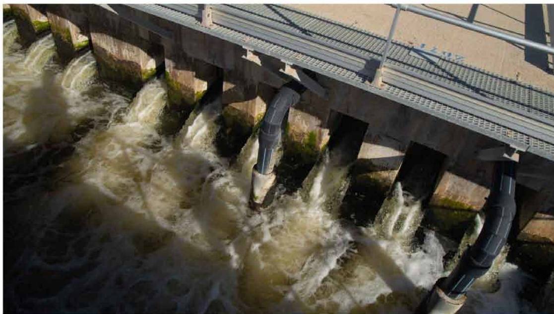
Microfiltración de agua de una estación depuradora de Aigües de Barcelona
