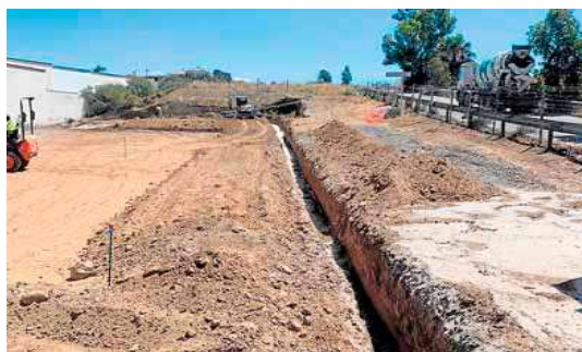
Trabajos en la parcela para instalar la desalobrador de pozos. SUR
