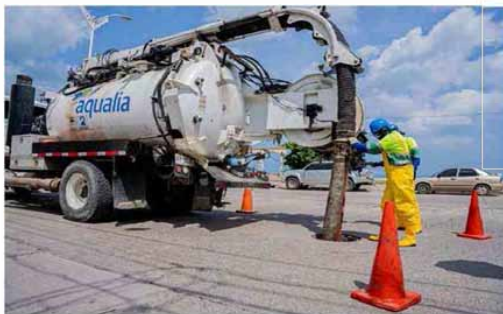
Aqualia refuerza el sistema de alcantarillado en Riohacha para prevenir inundaciones e insta a la comunidad a evitar arrojar residuos.
